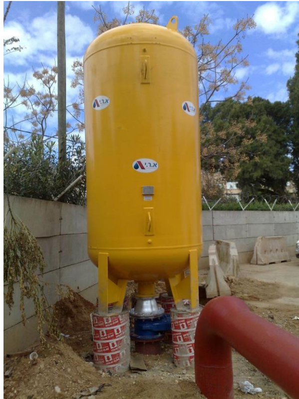
תמונה 4: התקנה של מכל הים שרוול גומי bladder בנתיה
