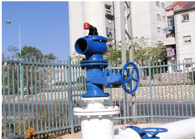
תמונה 2: שסתום אוויר משולב - דינאמי
